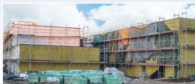
Budowa szkoły podstawowej w Sadowej przy ulicy Strzeleckiej
